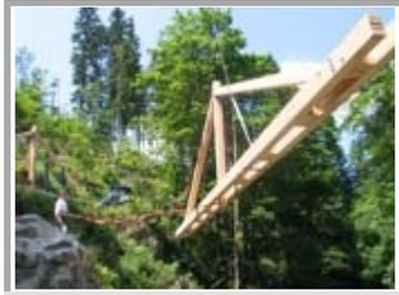
*Mit einem Autokran wurden die Hauptbinder des Teufelssteges mit einer Länge von 16 Metern und drei Tonnen Gewicht auf die Fundamente gesetzt.*
