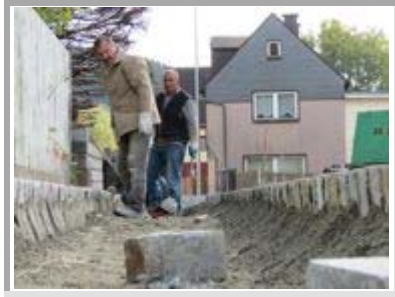
Es geht voran in Issigau: Die Arbeiter setzen Randsteine.
