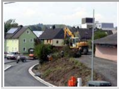
Die Arbeiten an der Böschung laufen bereits.
