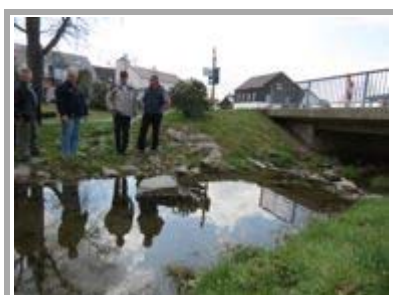
Wie die Springsteine gesetzt werden, darüber diskutierten (von links) Eddi Solger, der Firmenchef der STK Straßen- und Tiefbau Firma Bernhard Korkisch, Reinhardt Fröh vom Architekturbüro Schnabel aus Konradsreuth und Bürgermeister Dieter Gemeinhardt.
